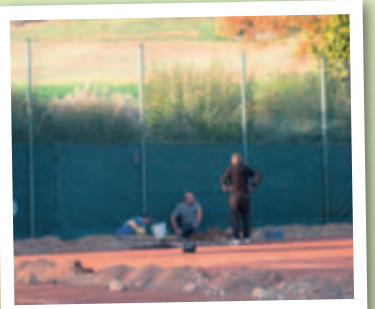
Verlegung der Leitungen für die Bewässerung
